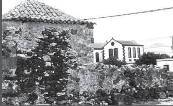
Casa de Tomás Mena y, frente a ella, el Hospital de La Ampuyenta, construido con su herencia. Fuente: Índice de ilustraciones (16)
